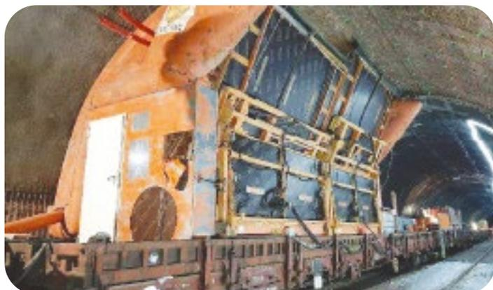
Depuis sa création, le tunnel ferroviaire, d'une longueur de 190 mètres, n'a connu aucun gros travaux de confortement. Suite à l'apparition de nombreuses détériorations (fracturation de briques, disjointolement, décollements ponctuels), il devient donc aujourd'hui nécessaire de le renforcer.
