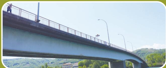
**Travaux :** Les peintures actuellement présentent sur les poutres et candélabres ont été réalisées en 1986 et contiennent du plomb. Ainsi, un décapage est nécessaire avant d'appliquer le nouveau coloris.
