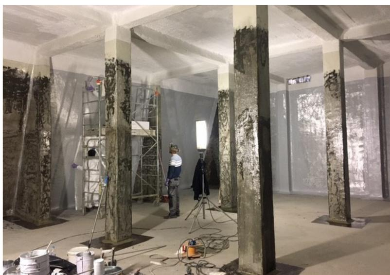
que la dégradation ne soit plus fulgurante. L'intervention consiste à créer un complexe d'étanchéité qui imperméabilisera les cuves.
