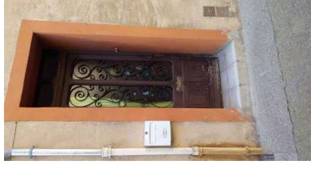
Apports lumineux par porte et imposte vitrés
