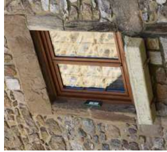
PVC et petits bois intégrés dans l'épaisseur du vitrage
