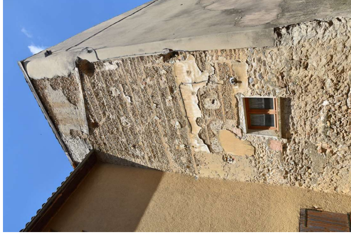
Utilisation du pisé sur des façades secondaires
