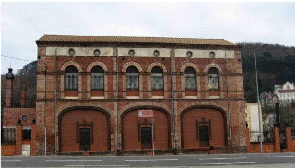
hourdis métallique en remplissage de brique.
