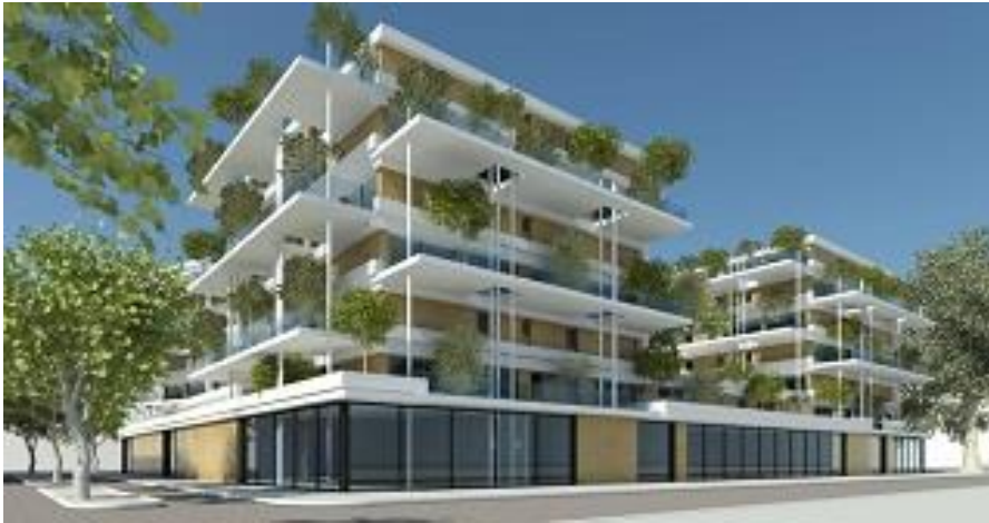
Socle dégageant une large superficie commerciale
