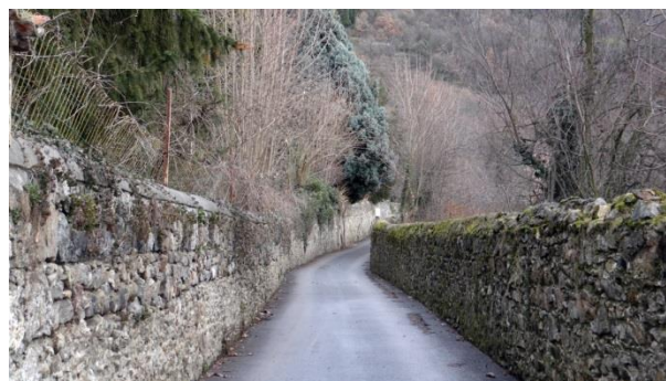
Murs anciens en pierres le long des rues
