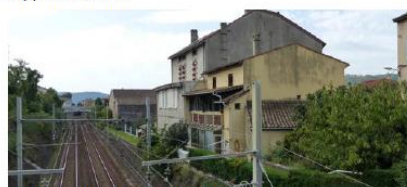
Jardins «suspendus» au dessus de la voie ferrée
