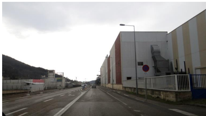
Façade industrielle de la ZA des Pierrelles en bordure de la RN7 et en entrée de ville
