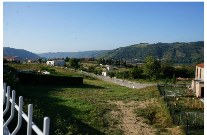
La ZAC de l'Ollanet aménagée en cours de construction
