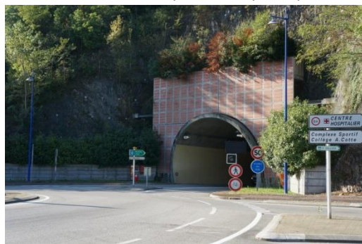
Entrée de ville Est par le tunnel de la RD 51
