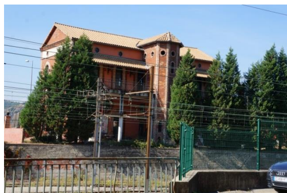
« La Tuilerie », ancien bâtiment industriel en briques de 1856 entre la RN7 et la voie ferrée
