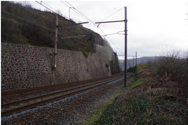
Aménagements de la voie ferrée au Sud de Saint-Vallier
