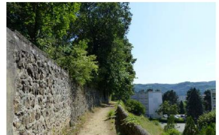
Fronaisons du parc du château des Rioux dépassant du mur de clôture le long du chemin des Aniers
