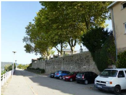
Alignement de platanes en surplomb de la rue du belvédère
