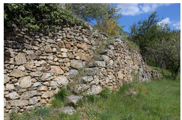
Mur de soutènement et escalier – Cote Magister
