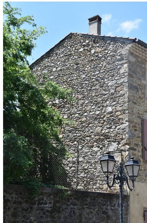
*Variété des types de pierres utilisées pour les maçonneries*
