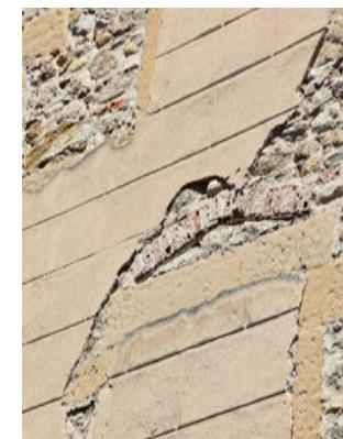
*Sous l'enduit apparaît la molasse des encadrements, la brique de l'arc de décharge*
